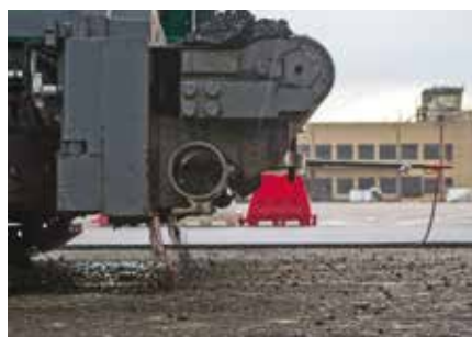
6. La macchina è equipaggiata con barre di spruzzatura che distribuiscono l'emulsione uniformemente e in funzione della velocità di stesa
