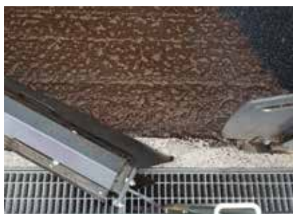
5. Grazie al sistema Spray Jet, è stata raggiunta una migliore precisione lungo i cordoli e le griglie per la raccolta delle acque meteoriche
