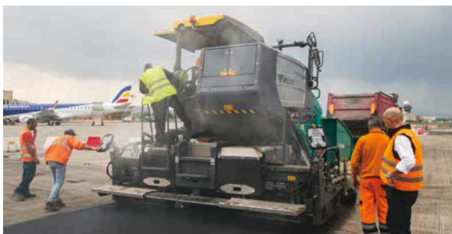
7. La Super 1803i Spray Jet ha evitato l'uso della spruzzatrice, portando a una maggiore rapidità con cui si riesce a concludere la stesa
