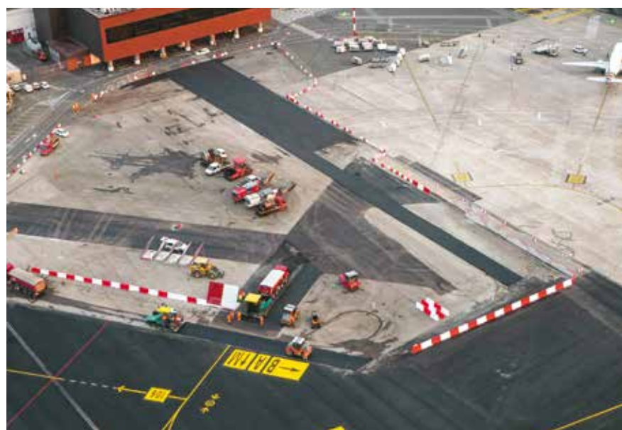
1. L'intervento di miglioramento e manutenzione dell'Apron 100 sul piazzale Est all'aeroporto di Firenze-Peretola "Amerigo Vespucci"
