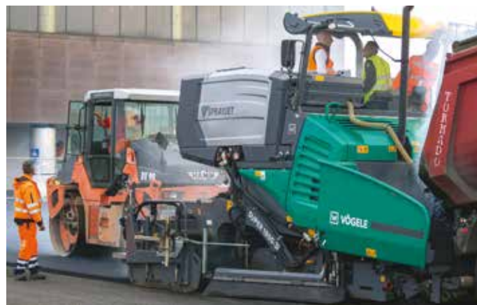
8. La finitrice è stata utilizzata con successo per stendere oltre 10.000 m 2 di strato di usura
